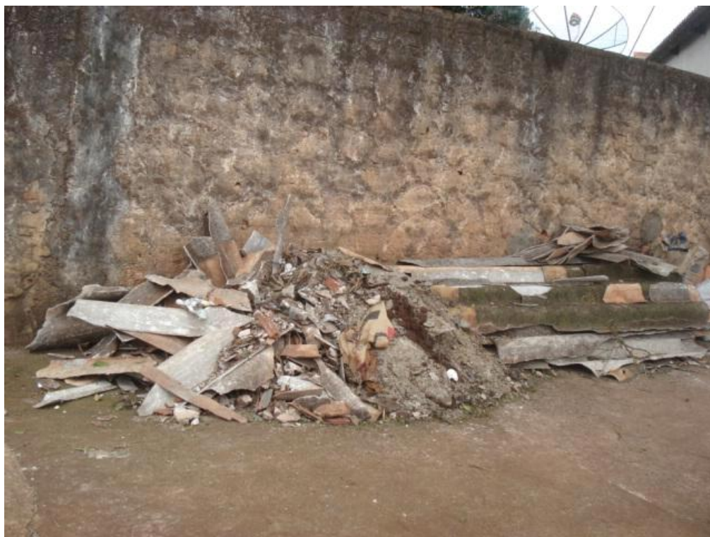
Figura 1: Vista de entulho em calçada
